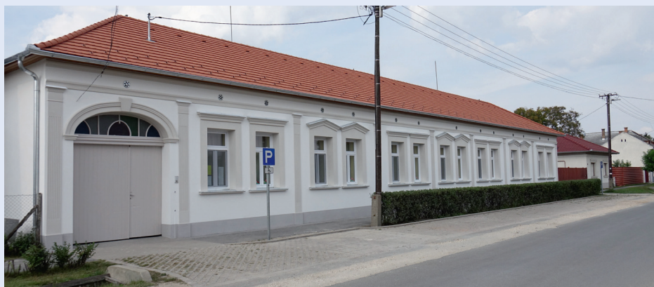
A Meserét Óvoda Szent Lajos u.-i Tagintézményének felújított épülete
